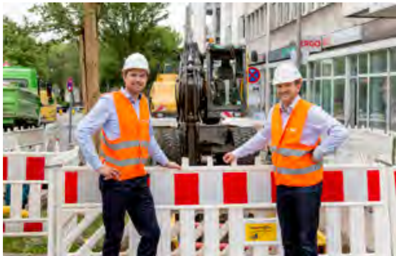
Bastian Stegemann (l.), Projektleiter bei DEW21, und Stefan Dettmer, Leiter Netz- und Anlagenbau bei DEW21, haben die Umstellung der Wärmeversorgung in der Dortmunder Innenstadt fest im Griff.
